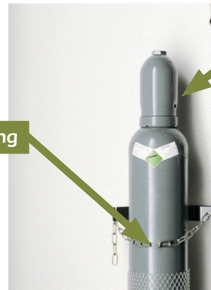
Ventilschutz durch Gewindekappe
